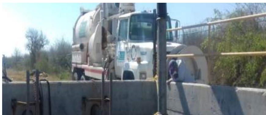
» Desazolve del cárcamo de bombeo con apoyo de personal de drenaje.
