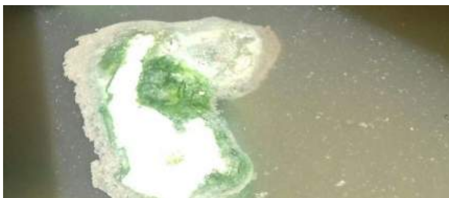
» Limpieza de canal y tubos de distribución de agua en el RAFA, y eliminación de sólidos generados en la superficie del reactor.
